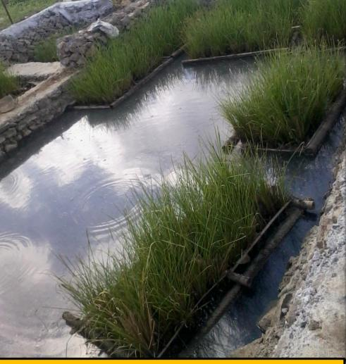
WATER FILTRATION SYSTEM **VETIVER PONTOONS ON GABION PONDS**
